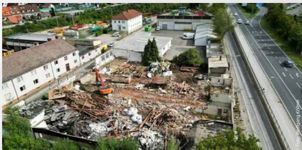
Ein Schandfleck weniger: Die Abbrucharbeiten sind bereits abgeschlossen.
